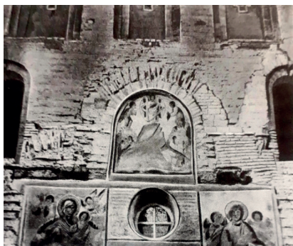
Илл. 4. Следы трёхлопастной арки на западной стене древнего храма
