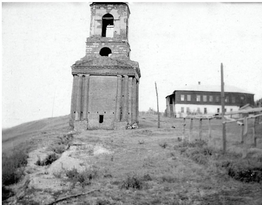
Рис. 5. На фото слева — монастырская колокольня, справа — Дмитриевская начальная школа (бывший настоятельский корпус). На переднем плане видны остатки фундамента разобранной стены-ограды. Вид с юга. Фото 1970-х гг.
